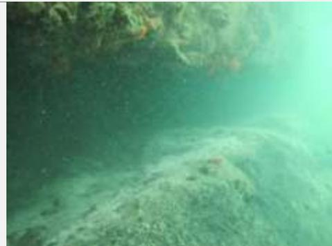
La cavité n°2, du bollard 7 à l'extrémité Sud du quai, présente une ouverture de 2,3 m de haut entre le béton du quai et le fond marin. Elle est située à -1,9 m de la surface. L'épaisseur de béton au-dessus du centre de la cavité est de 1 m..
