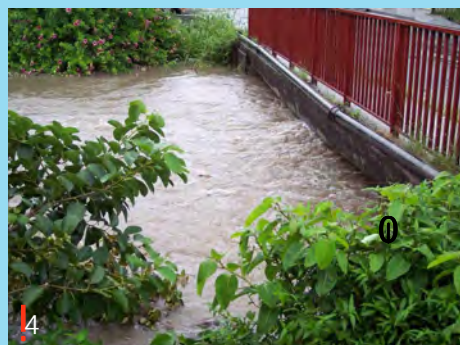
4 Ravine Bambara : mise en charge du pont RN9
