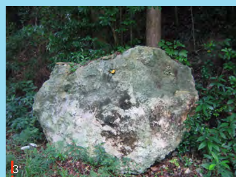
Gros bloc éboulé (1m3), RD 205, PK 14
