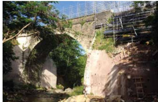
Construit au-dessus du Galion entre 1773 et 1780 sur les plans de l'abbé de Talcy, le pont ne comporte qu'une seule arche haute d'une trentaine de mètres. À l'origine, ses deux extrémités étaient formées par des tabliers de bois qui pouvaient être détruits pour contrer l'avancée d'ennemis.
