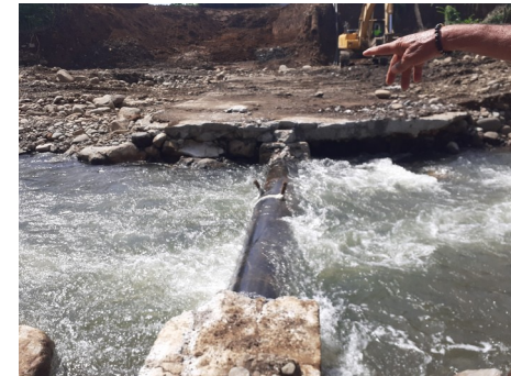
Protection de la canalisation AEP Gde Riv. Capesterre
