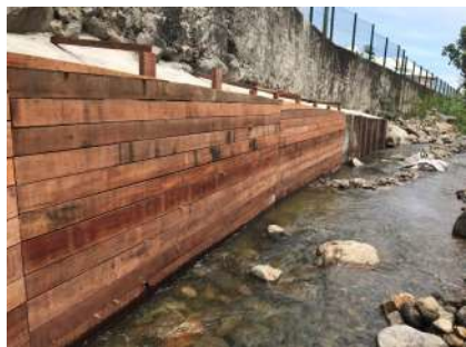
Rivière sens : mur EDF (après)
