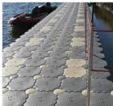
Figure 11 : Eléments pontons flottants modulaires
