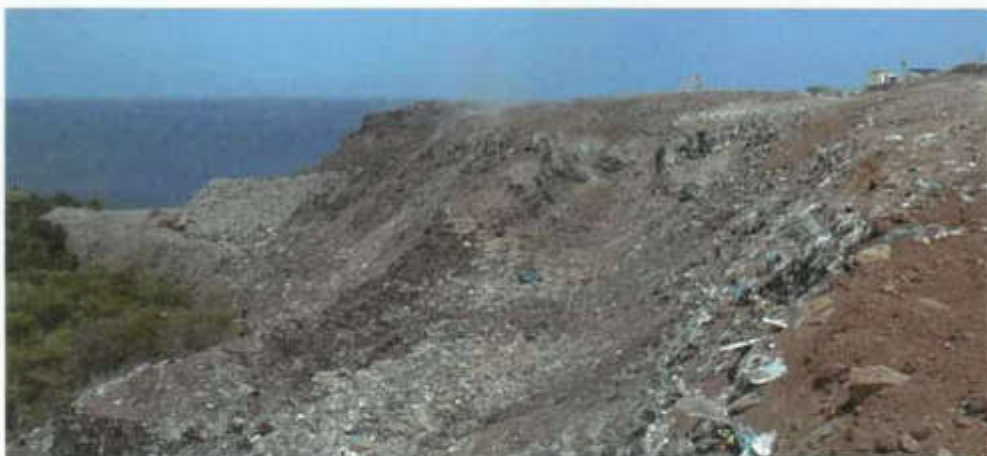
Vue de la décharge de Baillif en 2007
