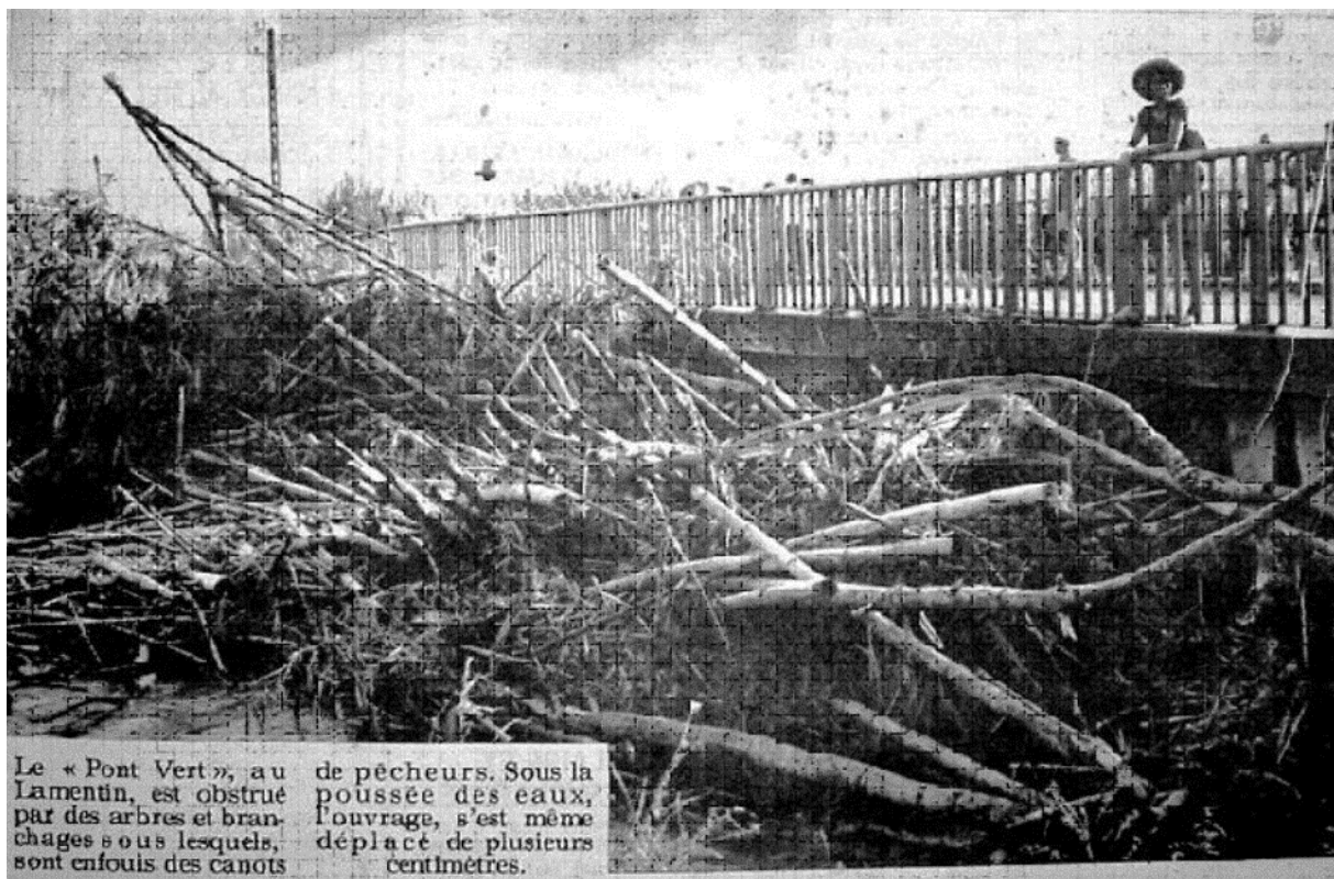
Figure 11 : Embâcle au niveau du Pont-Vert au Lamentin (en novembre 1966) [Source : France-Antilles]
