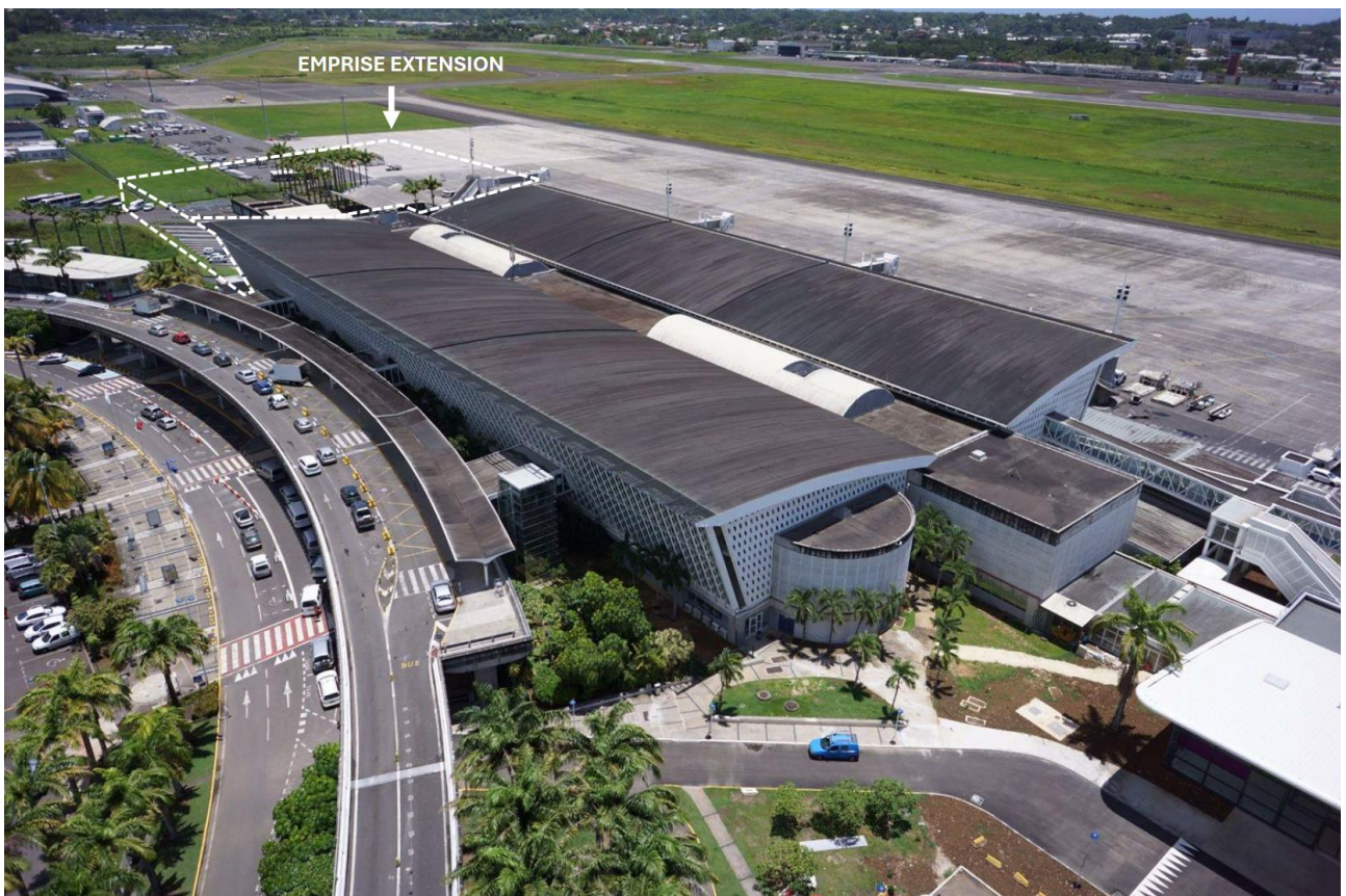
Figure 21 : Abords extérieurs de l'aéroport 2/2 (source : Notice paysagère, Enia)
