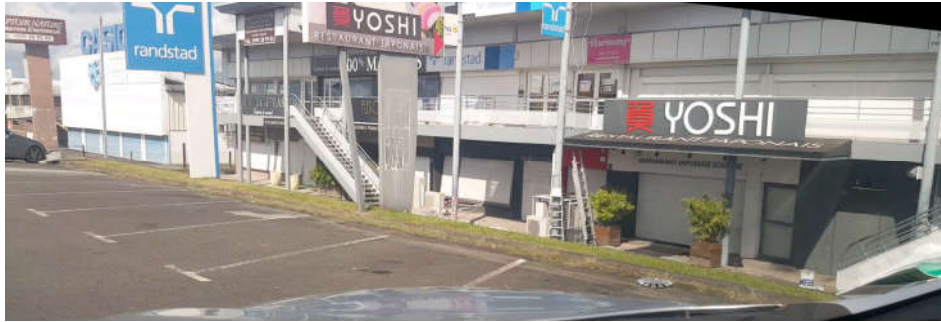
Différences de niveau entre l'espace public et la zone de parking de certaines enseignes en contrebas. Absence de garde corps et de chasses roues pour les véhicules.
