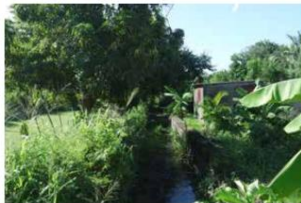
4- Canal à ciel ouvert
