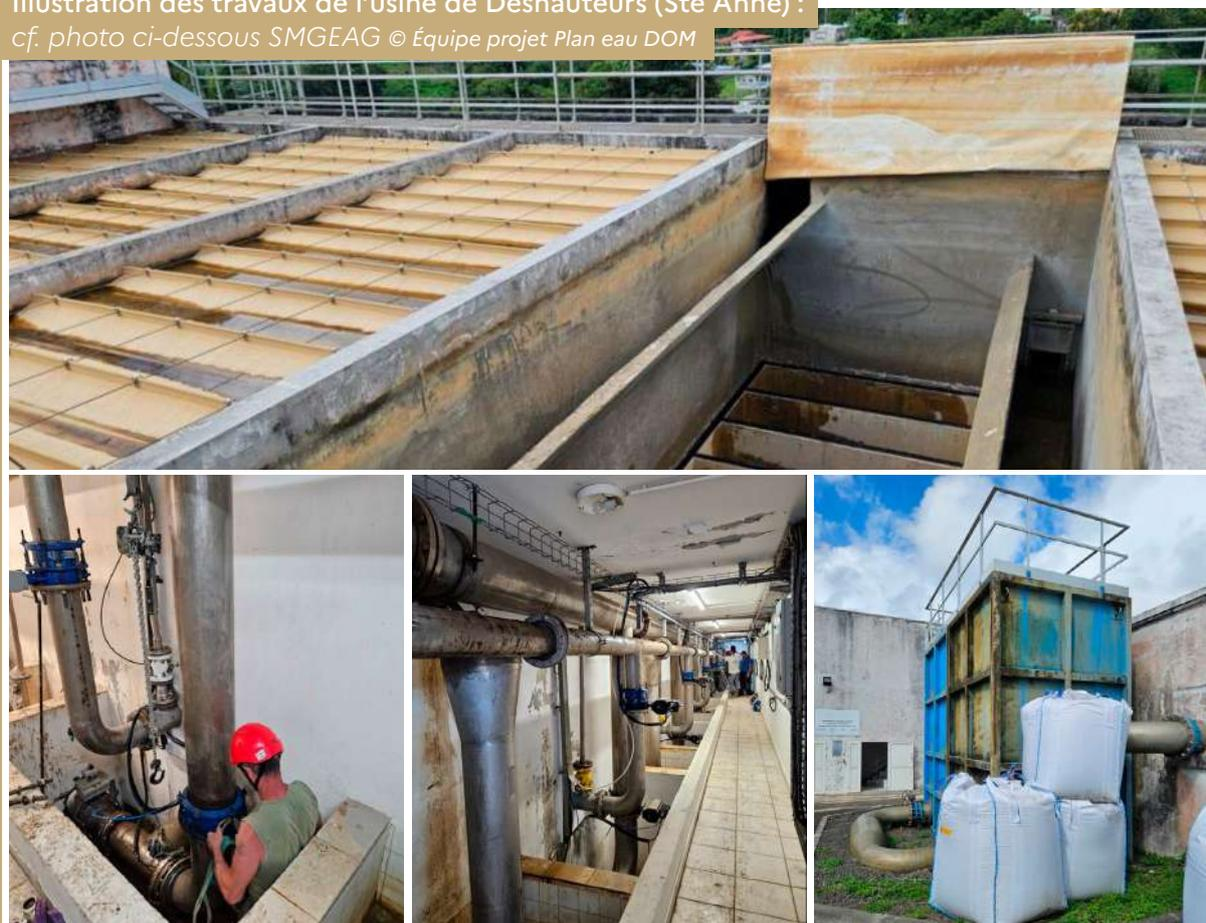
Filtere n°4 / Intervention sur le siphon / Chambre sortie filteres à sables / Stock de sable
