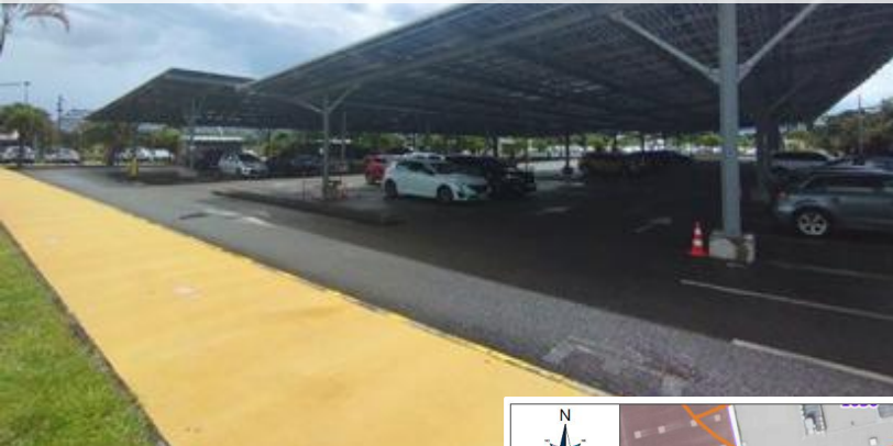
AMO ombrières avec stockage 1,5MWc Cayenne (973) – TOTAL
