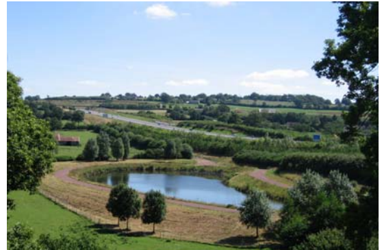
Mesure de réduction : insertion paysagère d'un bassin d'assainissement sur A84 (CETE Normandie-Centre)
