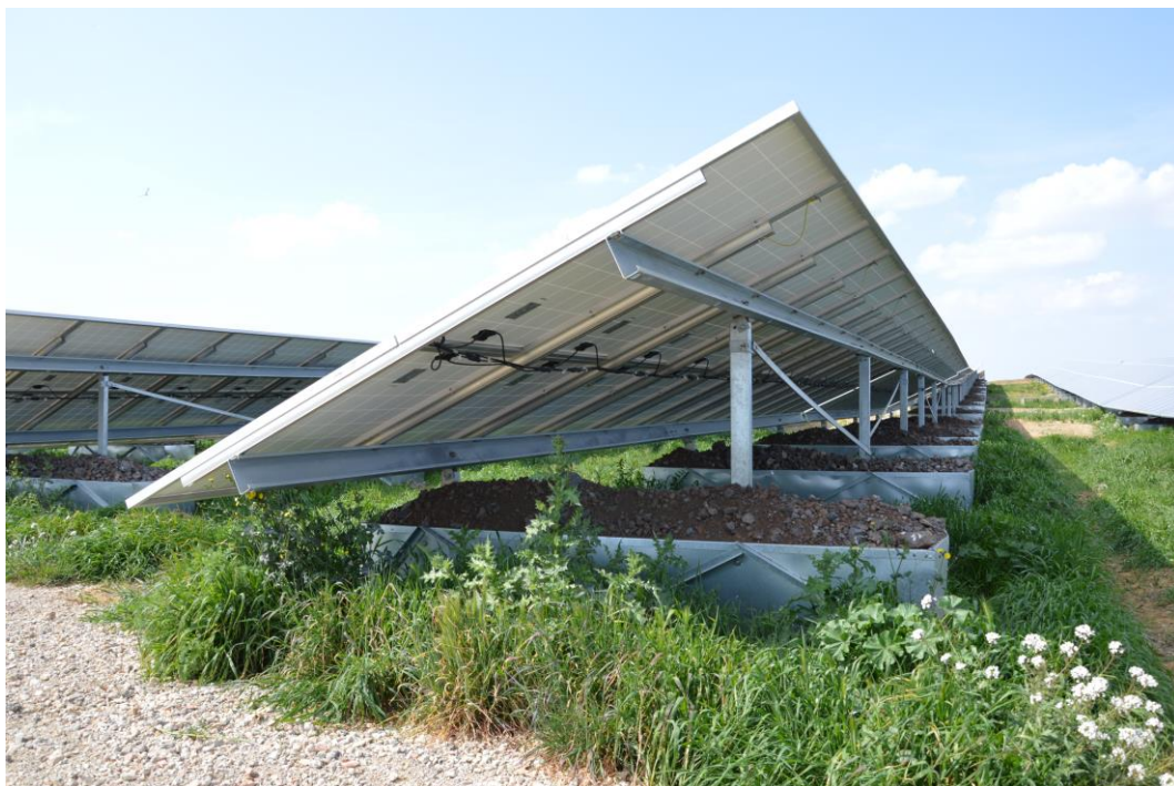
Figure 56 : Exemple d'ancrage par plot autoportant (gabions) -Source : Quadran Caraïbes
