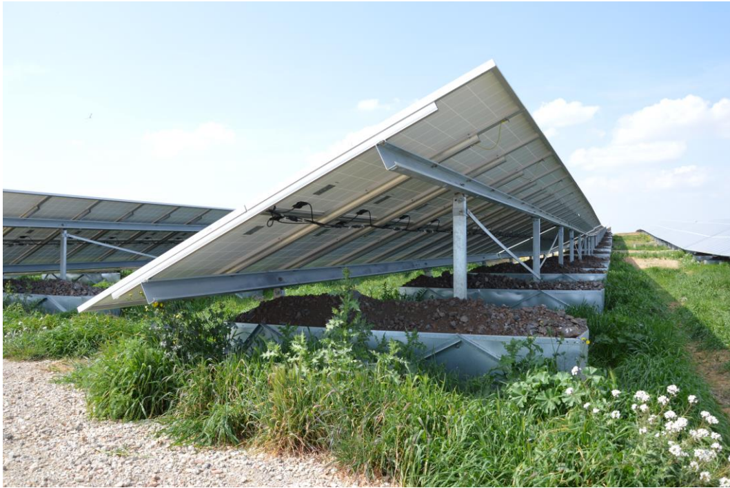
Figure 44 : Exemple de plots autoportants de type gabions - CET de Libron (Source : Quadran)
