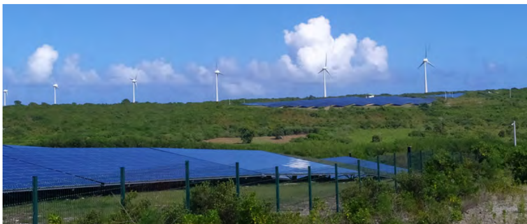
Ferme photovoltaïque à Petit Canal © DEAL Guadeloupe
