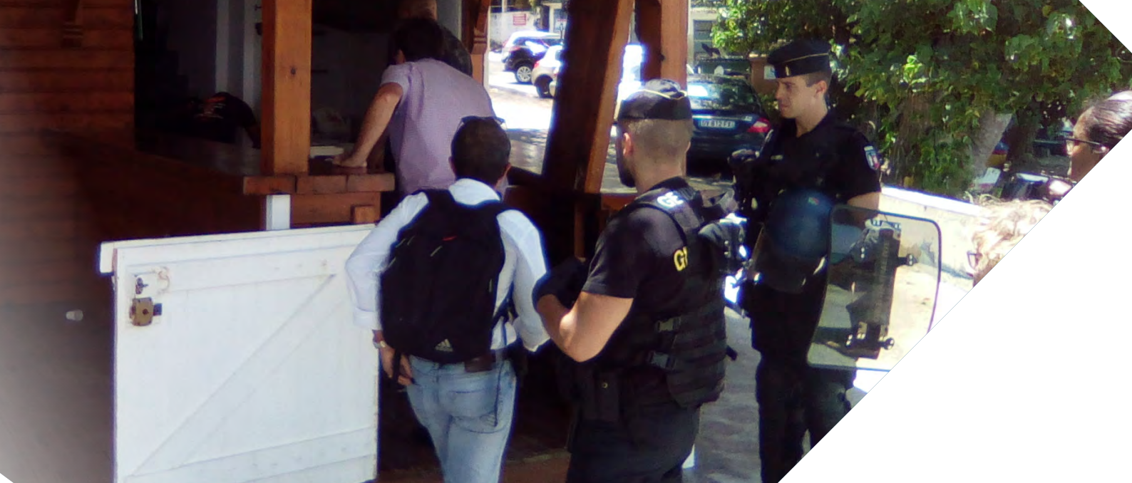
Démolition d'un restaurant de plage illégal au Gosier (cliché DEAL)
