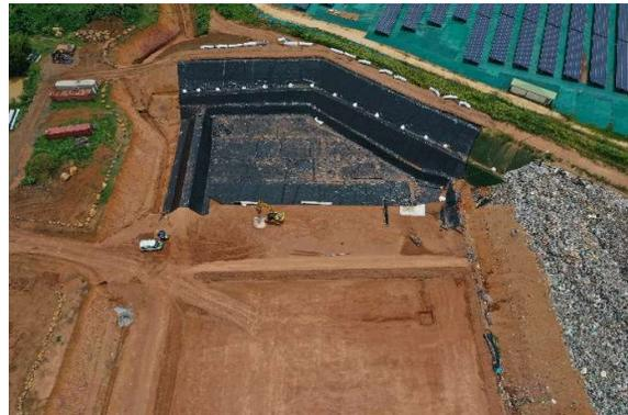
Figure 26 – Travaux d'étanchéité sur K2
