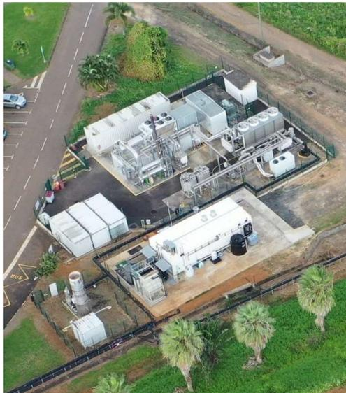
Figure 12 : zone technique de traitement des effluents – au premier plan, nouvelle station de traitement des lixiviats, et torchère / vapo therm, et moteur de valorisation du biogaz en arrière-plan
