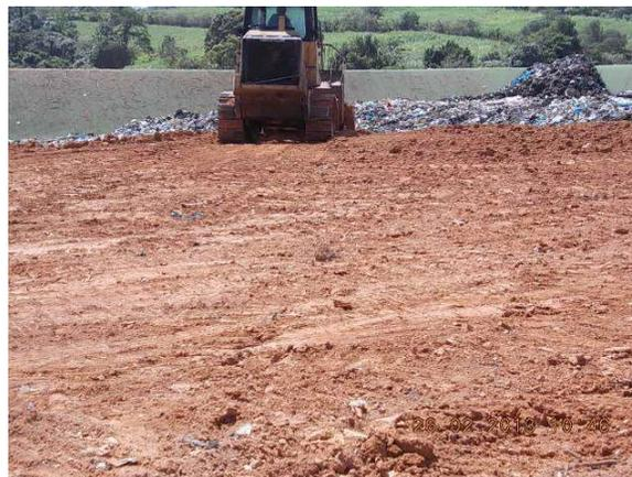
Figure 27 - Aménagement d'une couverture provisoire
