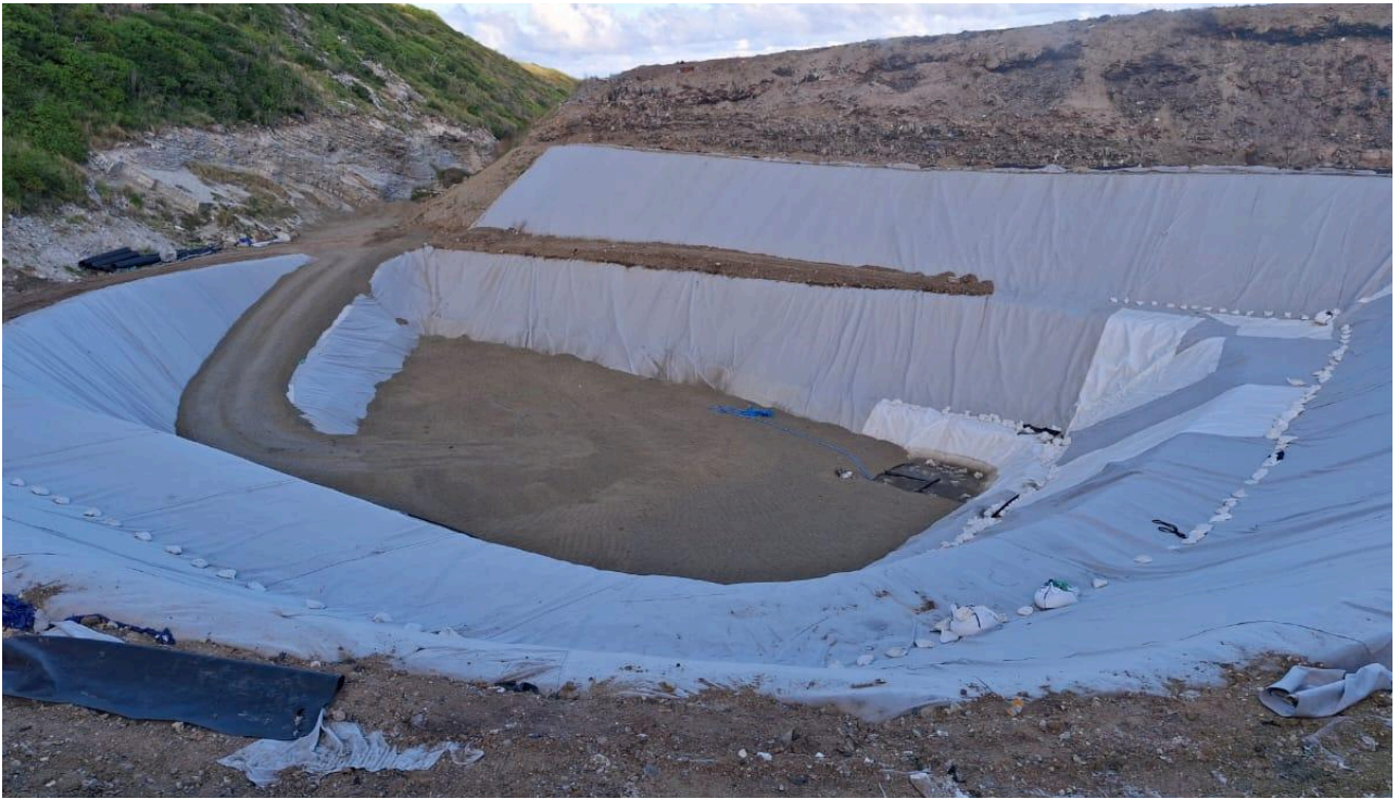
Figure 16 : Couche de drainant de 50 cm dans le fond du casier pour le drainage des lixiviat
