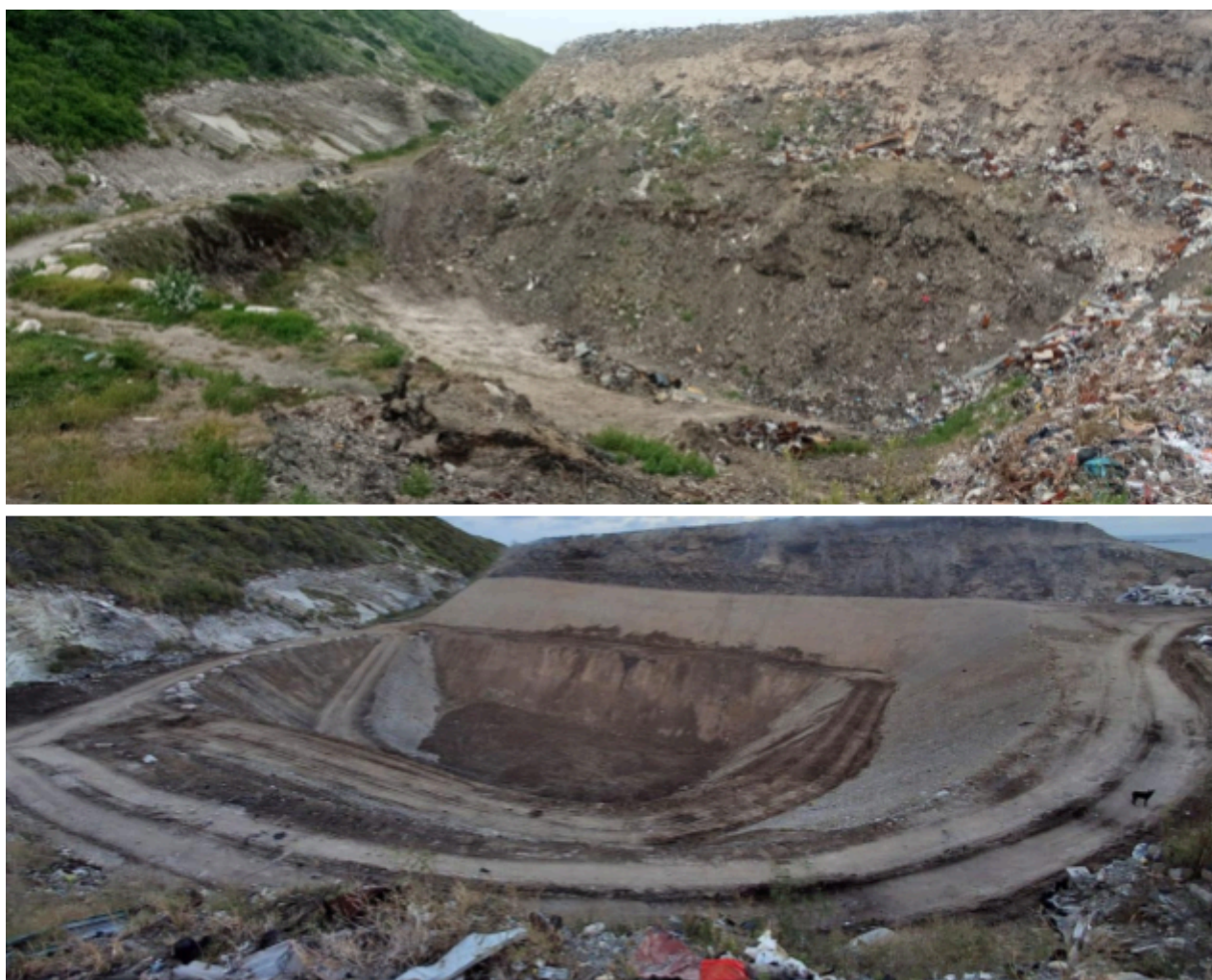
Figure 13 : Terrassement effectué pour la construction du casier
