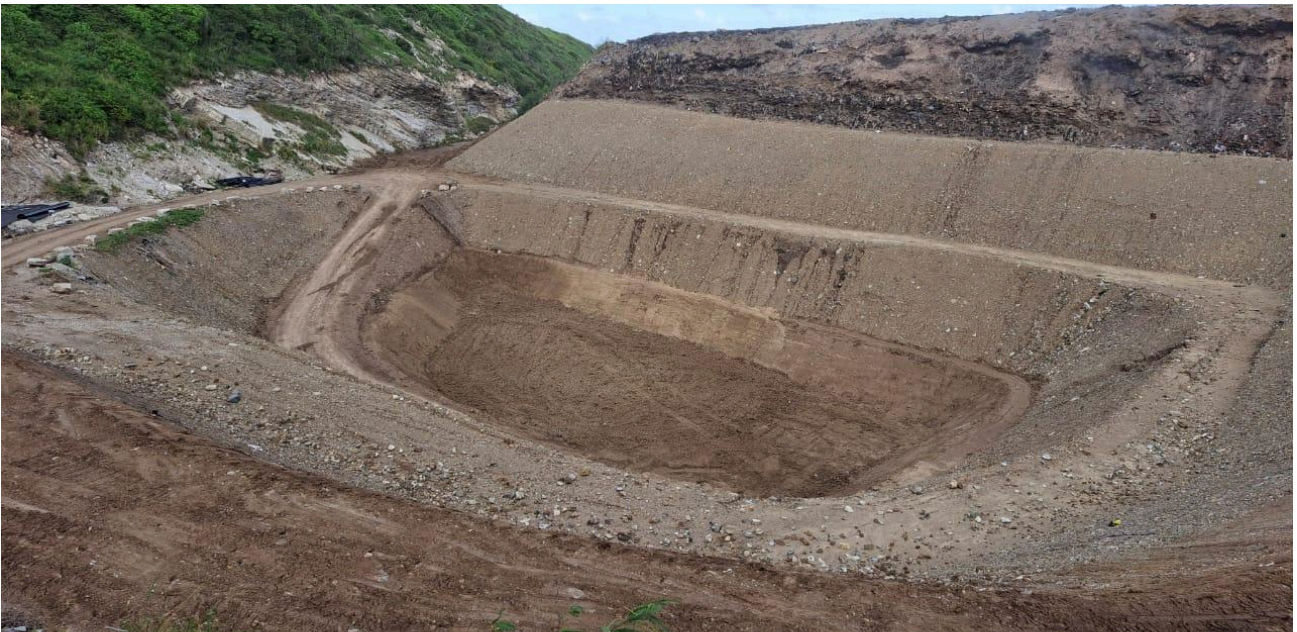
Figure 14 : Couche d'argile (BSP) posée dans le fond et sur une partie des flancs du casier
