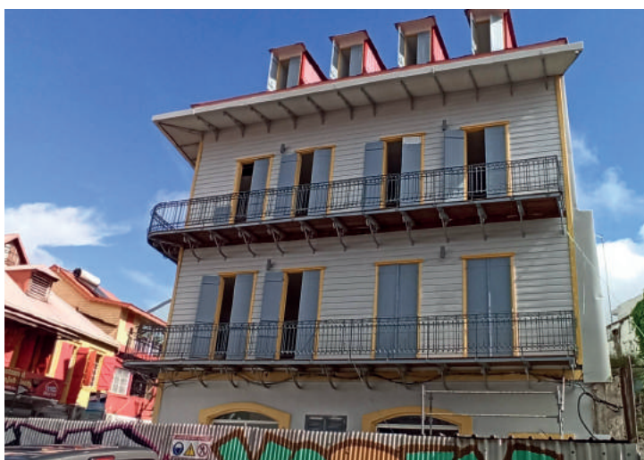
Avant et après rénovation d'un bâtiment à Point-à-Pitre
