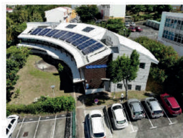
Bâtiment des Douanes Bougaivilliers (livré en 2019 - MO).
