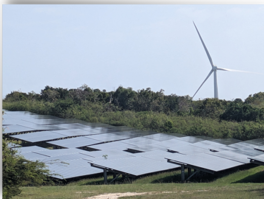
Éolienne et panneaux solaires
