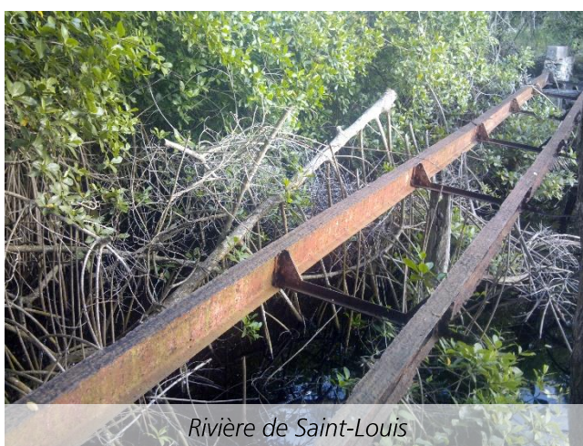
Figure 15 : Passerelles dégradés observés en 2020
