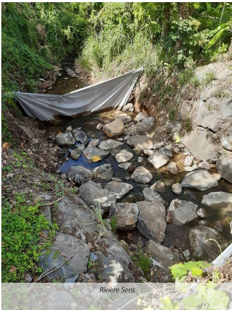
Figure 16 : Travaux en cours dans les cours d'eau pendant la mission terrain 2022
