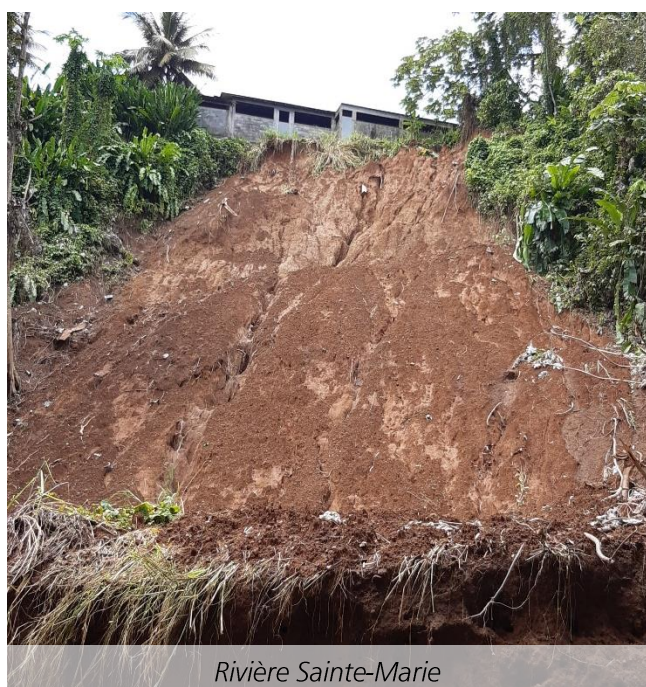
Figure 11: Zones d'éboulement observées en 2022 menaçant la sécurité des biens et des personnes
