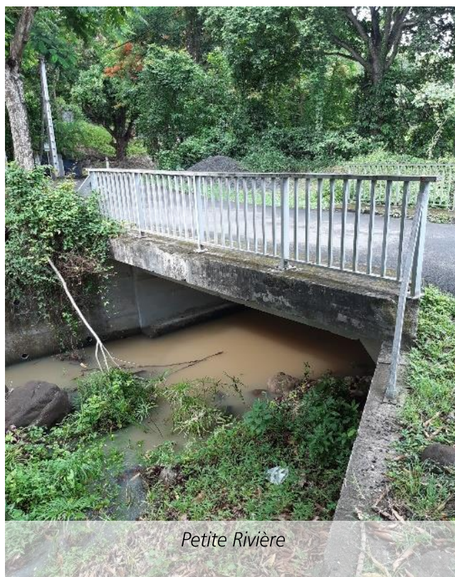
Figure 24 : Travaux de curage préconisés
