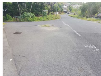
Intersection avec la route de la plage de l'Etang, à gauche
