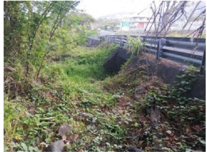
Ouvrage sur la ravine Bel-Air, amont
