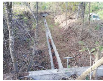
Ouvrage hydraulique côté terre
