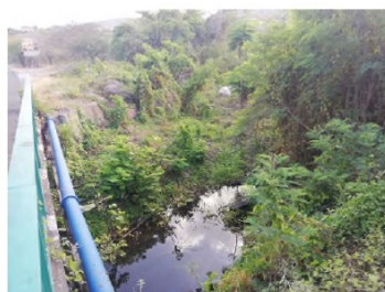
Ravine Géry à l'amont de l'ouvrage d'art
