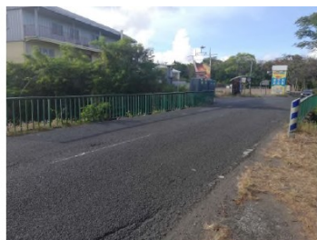
Ouvrage sur la ravine Géry et vue sur l'intersection
