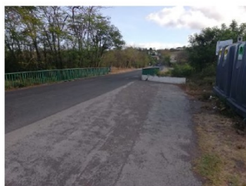
Accotement revêtu entre l'intersection et la ravine de Géry
