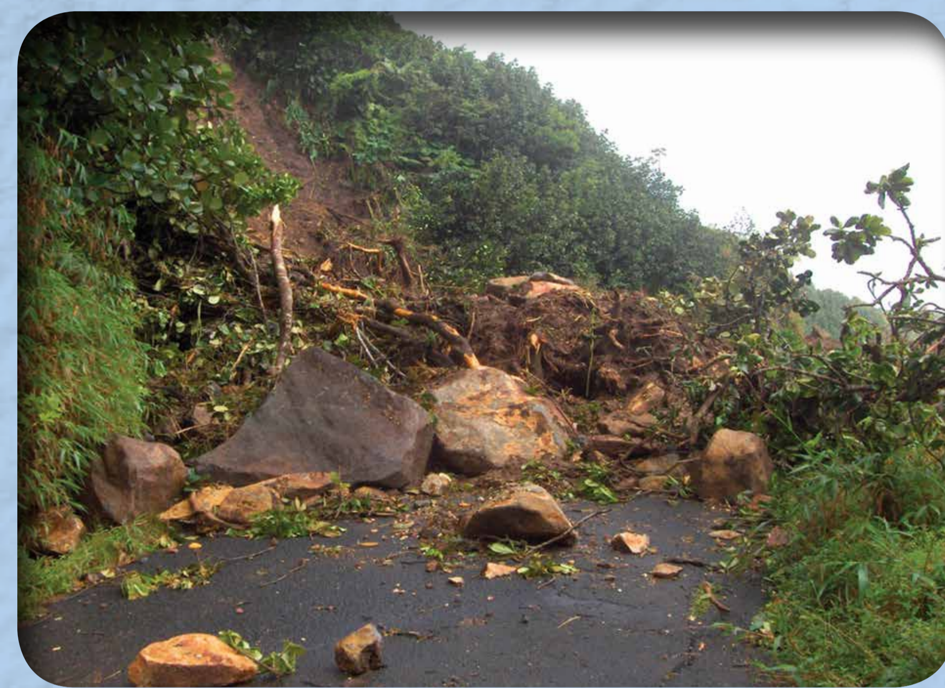
Route bloquée suite à l'éboulement du Piton Tarade (massif de la Soufrière), provoqué par le séisme des Saintes en 2004 © F. Beauducel/PGP, 2004
