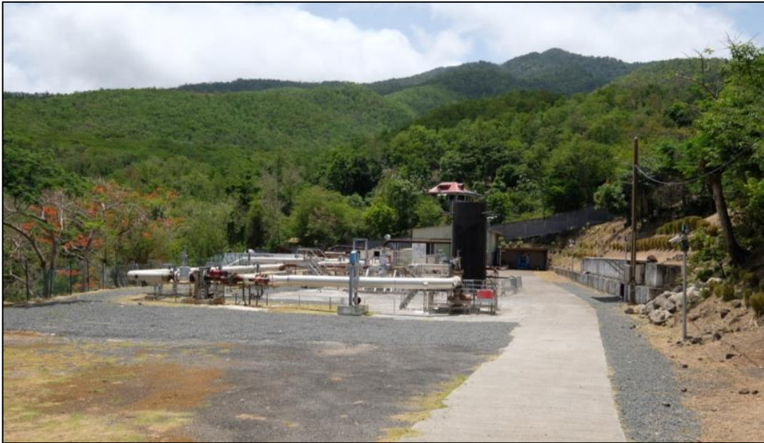
Figure 9 : Vue de la plateforme actuelle des puits à Plateau. Le puits BO-12 sera implanté au fond dans le prolongement des installations actuelles.
