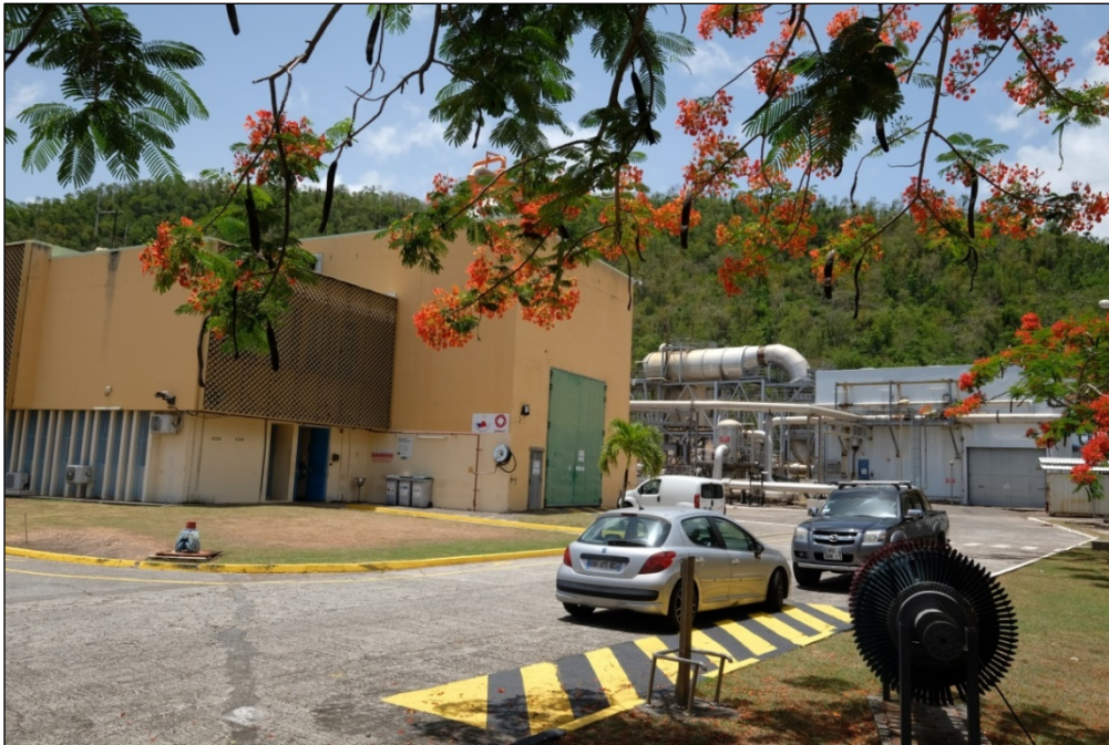
Figure 21 : Vue du bâtiment de couleur beige de l'unité Bouillante 1 abritant le groupe turbo-alternateur de 4,5 MW (à gauche) et du bâtiment de couleur bleu ciel de l'unité Bouillante 2 abritant le groupe turbo-alternateur de 11 MW (au fond à droite).
