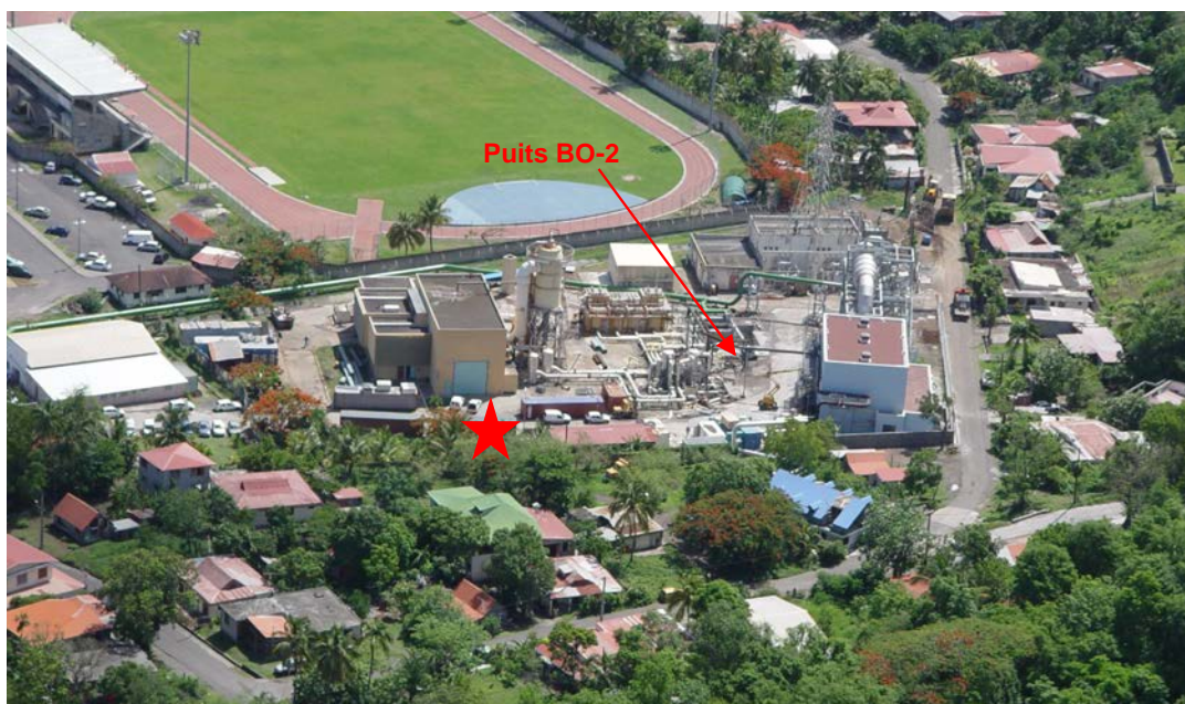
Figure 8 : Photographie aérienne montrant la centrale géothermique de Bouillante dans son environnement. L'étoile rouge indique l'implantation approximative du puits BO-11.
