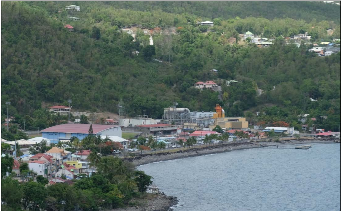
Figure 22 : Vue distale du bourg de Bouillante depuis le point de vue de Falaise, où l'on distingue les installations de la centrale géothermique comme élément marquant du paysage.
