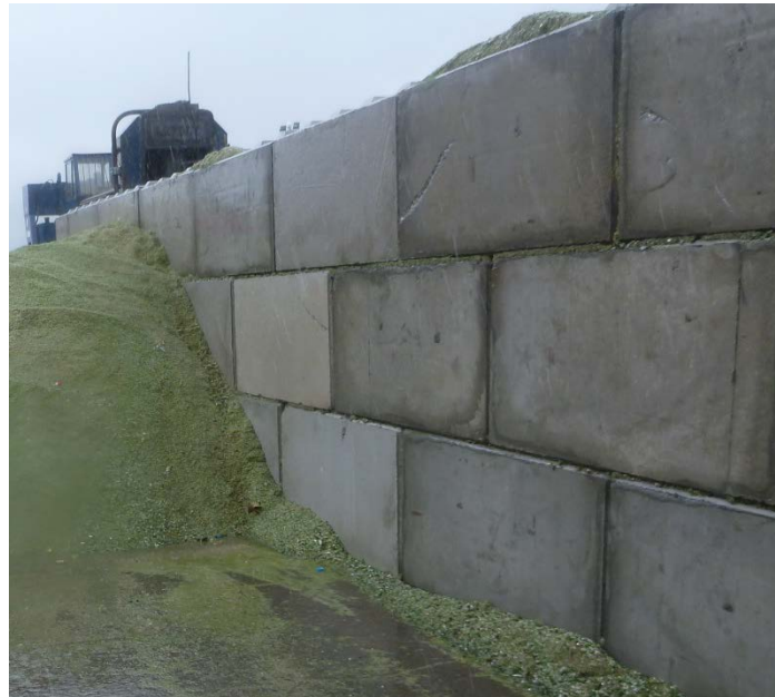
Illustration 34 : Blocs Transbéton (Site AER).
