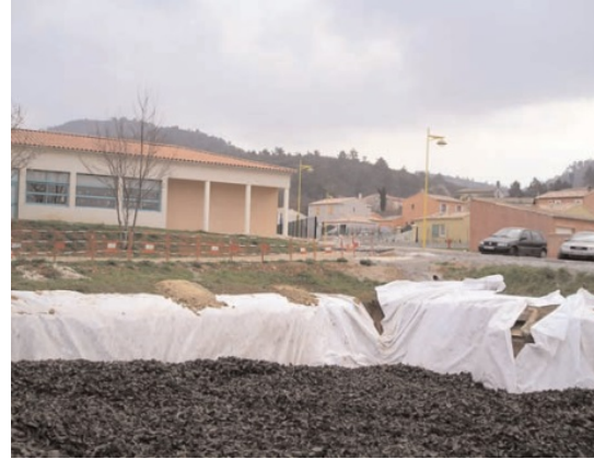
Bassin de rétention
