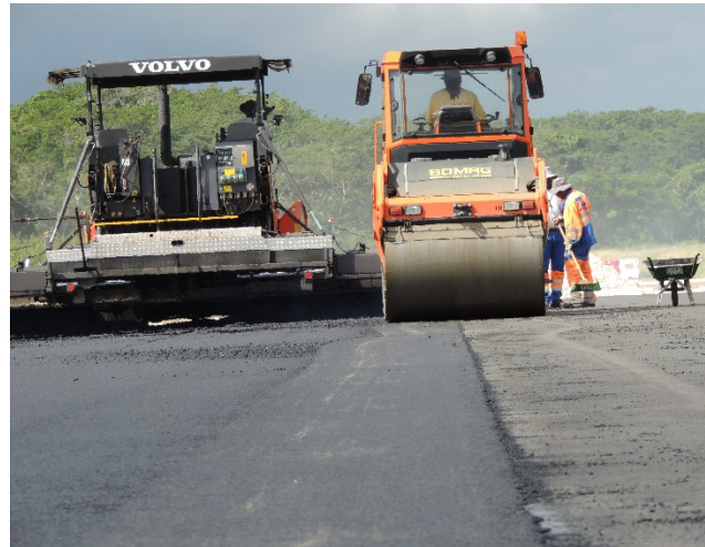
Engins sur chantier
