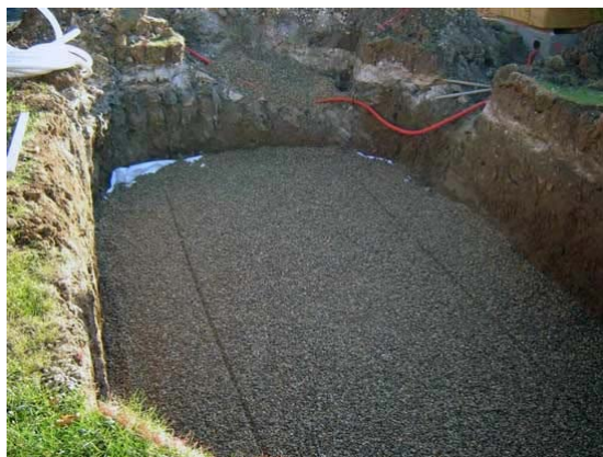
Illustration 17 : Matériaux issus de gravats inertes utilisés en remblai.
