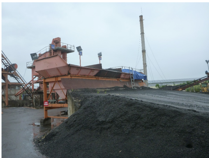
Illustration 38 : Mélangeur de matériaux pour la production d'enrobés (SGEC).
