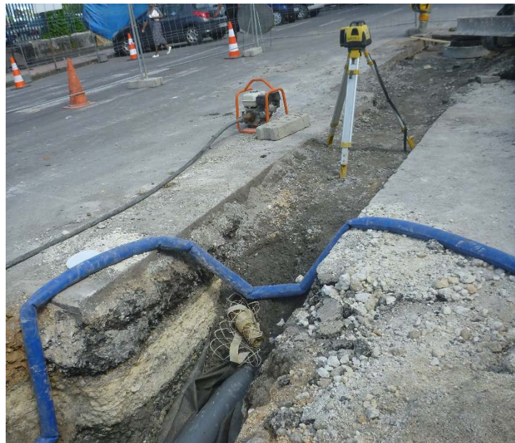
Illustration 13 : Chantier de remblaiement de tranchée avec du gravier recyclé à Pointe-à Pitre (chantier Getelec).
