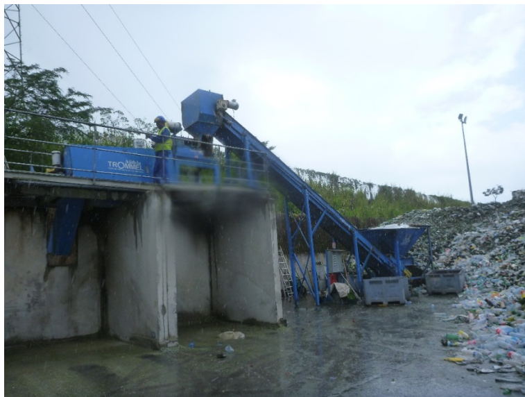
Illustration 29: Installation de recyclage du verre usagé (AER).
