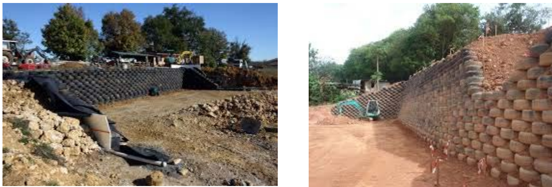
Illustration 28: Exemple de murs de soutènement réalisés avec des pneus usagés.
