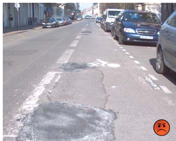
Revêtement dégradé pénalisant la circulation du cycliste
